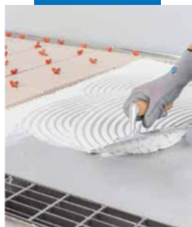
Укладка напольного или настенного покрытия с применением Kerapoxy Design
