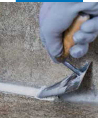
Создание угловых швов
