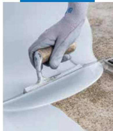
Нанесение Maregut EPX
