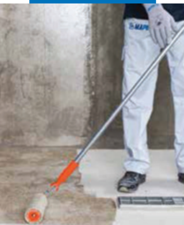
Нанесение Primer SN на основание
